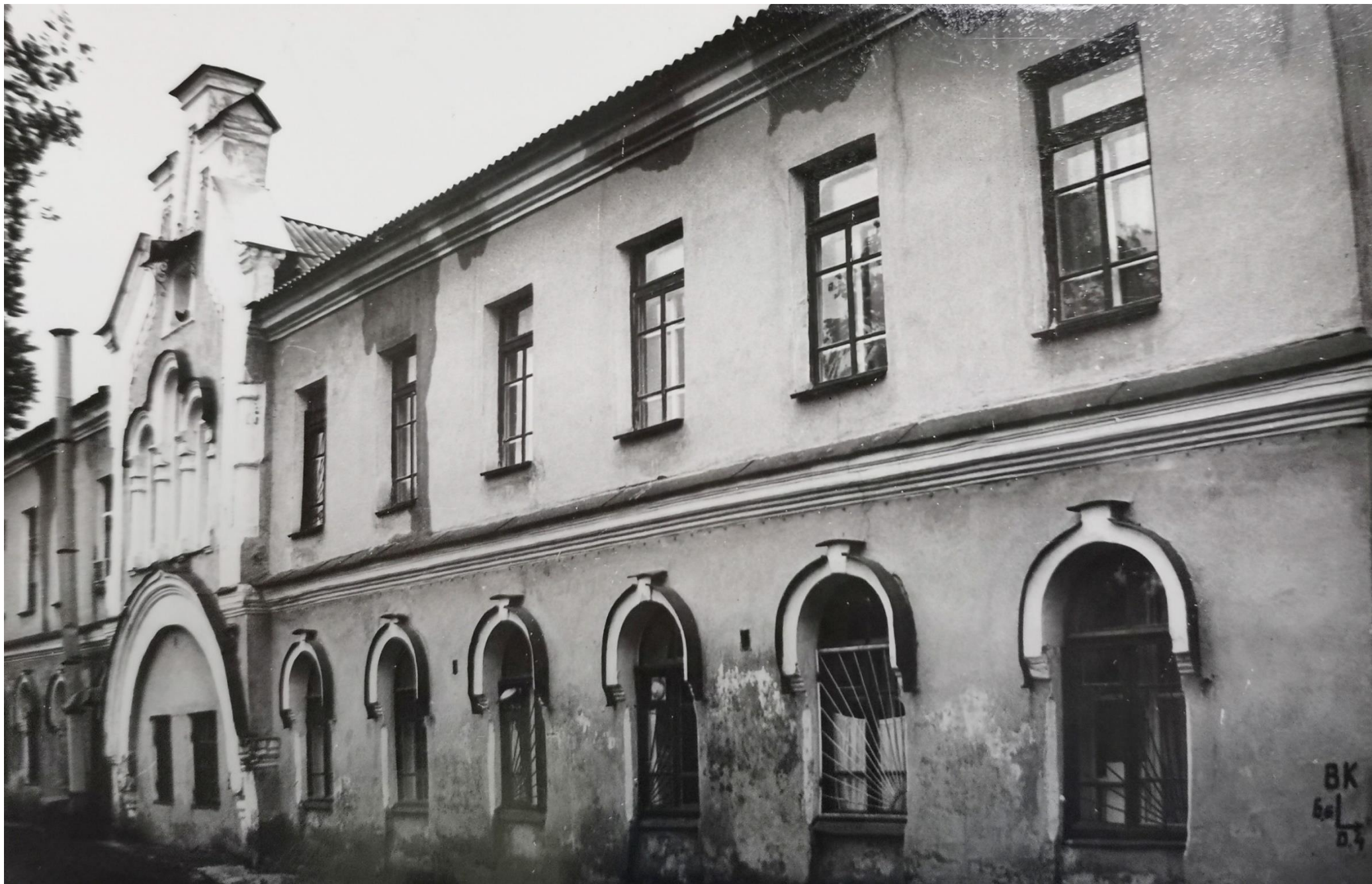
Надвратный корпус подворья Псково-Печерского монастыря
